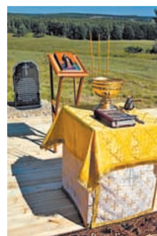
11 августа. Освящение закладного камня в основание нового храма в честь святителя Василия Рязанского в д. Протекино
