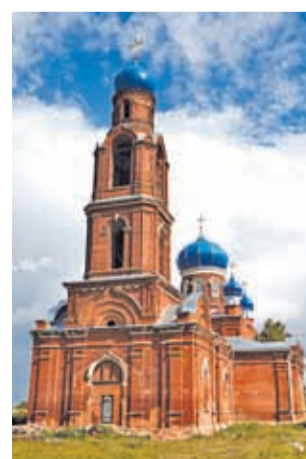
В летние месяцы проводились ремонтно-восстановительные работы на колокольне Благовещенского храма д. Клинь-Бельдин
